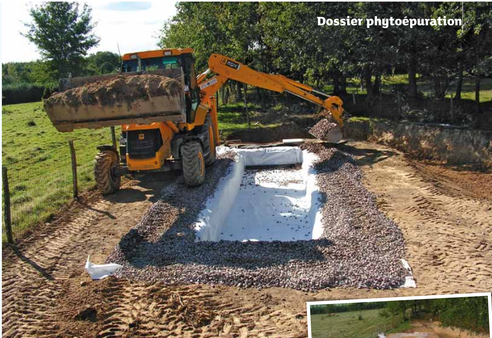
Chantier en cours, si les bassins sont peu profonds, ils nécessitent l'intervention d'une pelleteuse.
