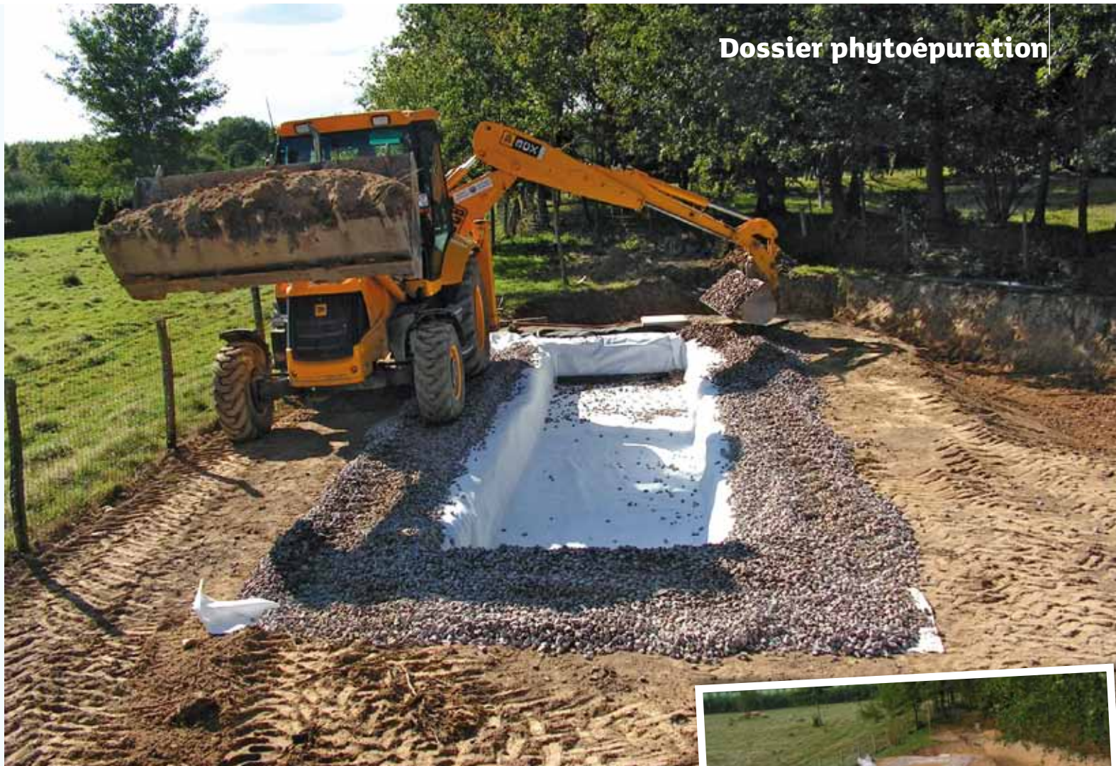
Chantier en cours, si les bassins sont peu profonds, ils nécessitent l'intervention d'une pelleteuse.
