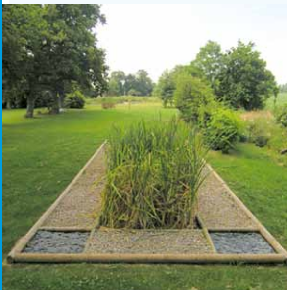
Bassin horizontal terminé.
